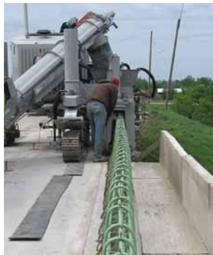
Pouring barrier over rebar cage.
